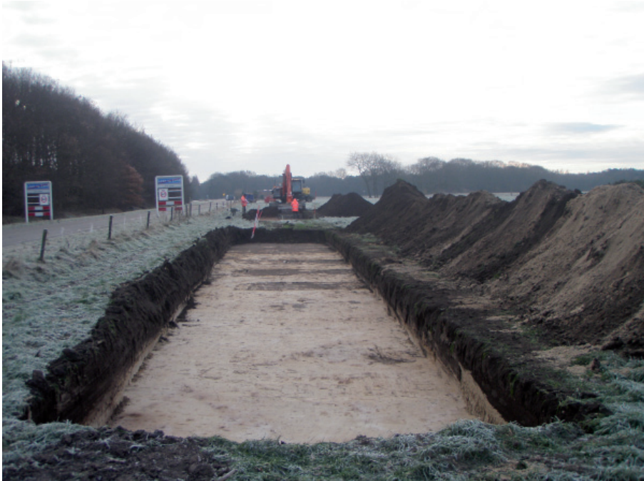
Afbeelding 5. Overzicht van de werkzaamheden.
